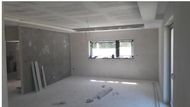
stropní konstrukce min.vlna hr. 30cm, sádkartonový podhled, stropní výlez
