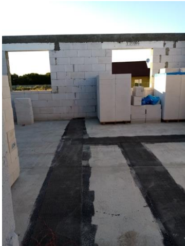
asfaltová hydroizolace proti zemní vlhkosti v interiéru a exteriéru stavby
