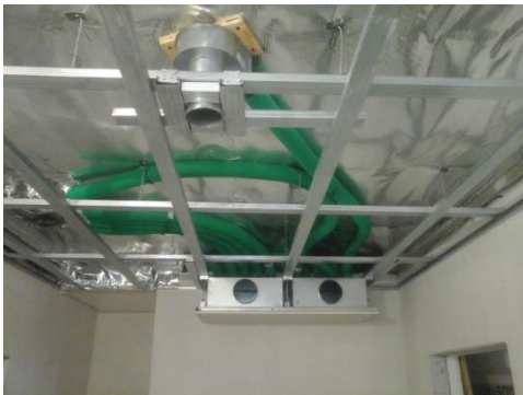
stropní konstrukce min.vlna hr. 30cm, sádkartonový podhled, stropní výlez
