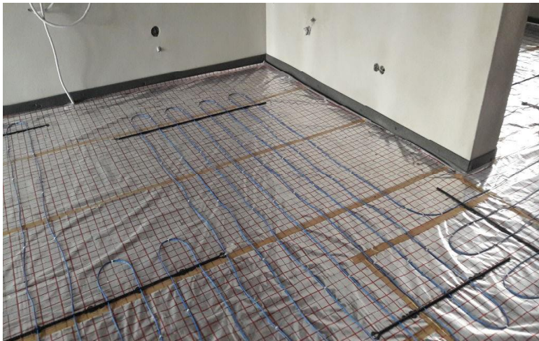
topení elektrické podlahové s dvoužilovým kabelem, regulační termostat s inteligentním ovládáním
