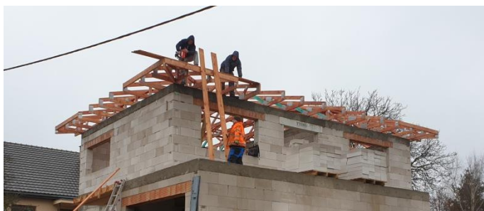
vazníkový krov, betonová/pálená/plechová krytina, okapový systém pozinkovaný barevnost podle výběru
