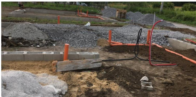
kanalizační rozvody KG pod deskou, uzemnění bleskosvodu
